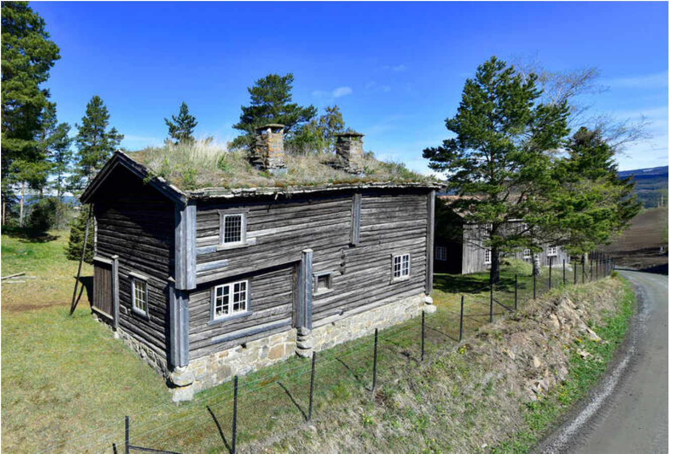
Vienbråten ligger i idylliske omgivelser, men likevel supersentralt rett ved Kongeveien.
