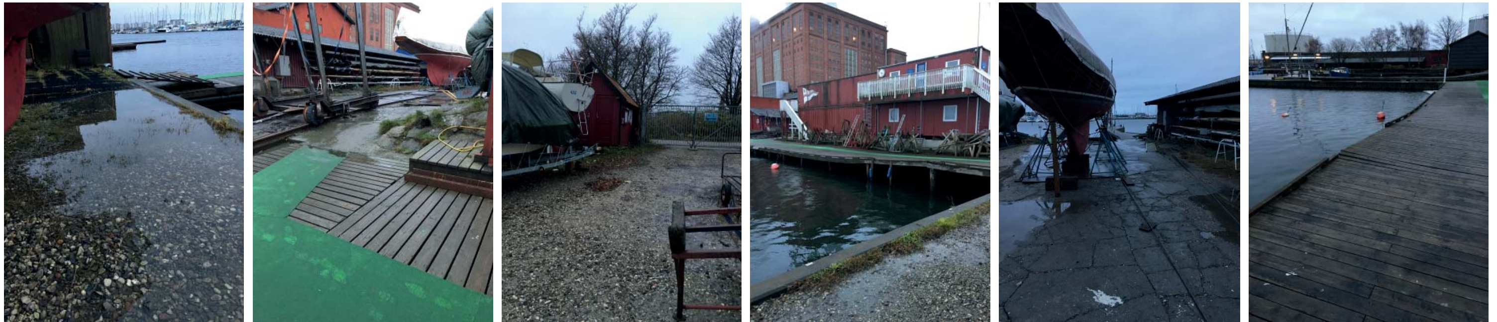
KAS eksisterende forhold Besigtigelse december 2017
