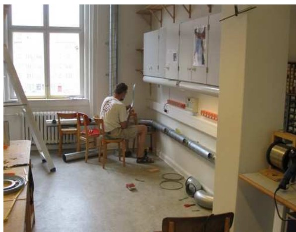
Per er her ved at montere udsugningsrør til det nye loddebord.
