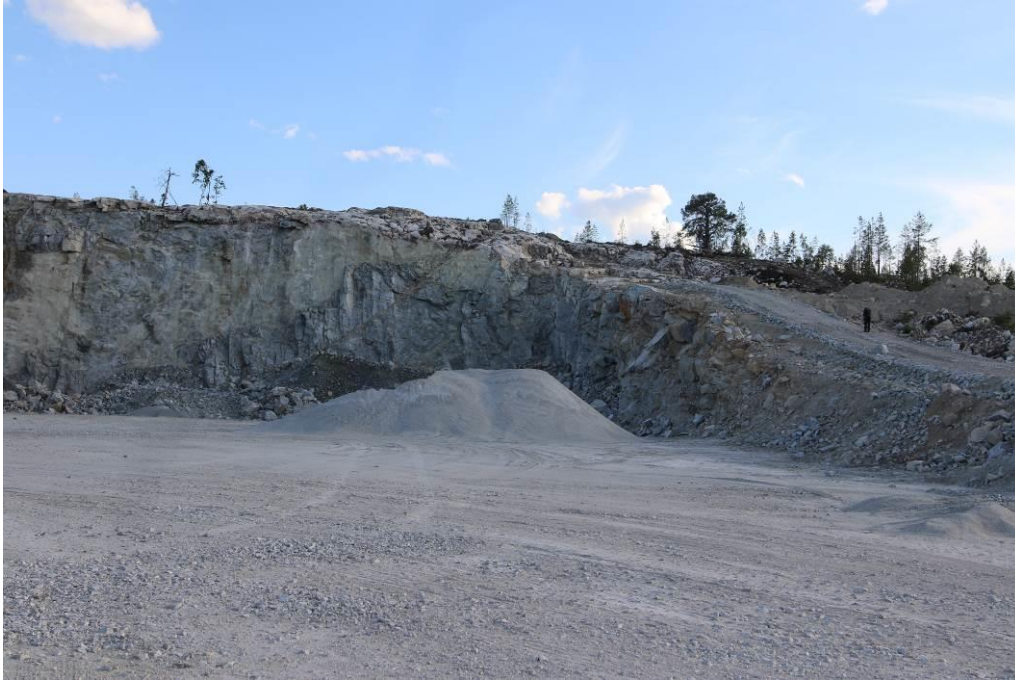
Den västra pallväggen med sprickfattigt berg.
