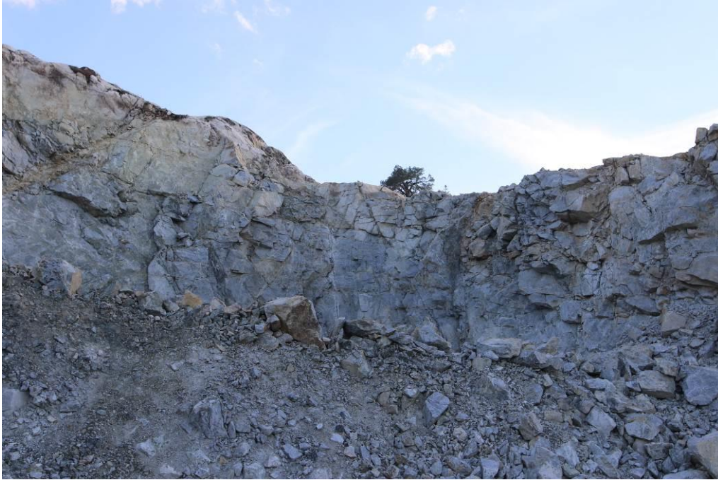
Närbild på sprickfattigt berg i västra pallväggen.
