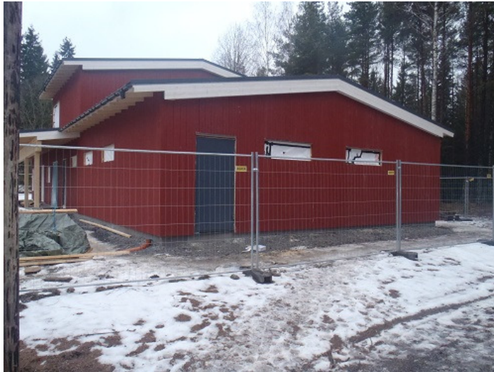
2014-02-04 Byggställningen monterades ner idag och här ser vi också att ståldörren till teknikrummet kommit på plats
