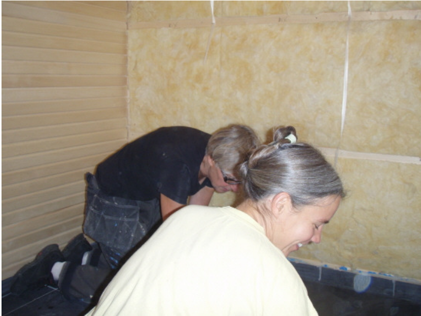
2014-10-26 Och så här glada var de när de nästan var klara. Här ser vi också Unos pågående arbete med bastupanelen i bakgrunden
