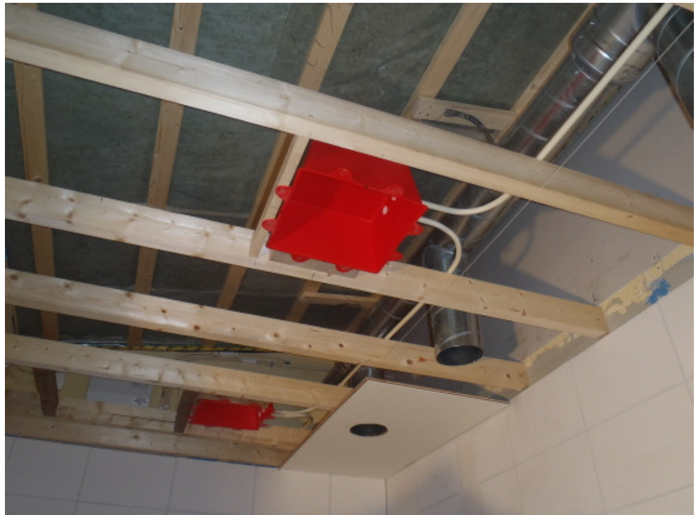
2014-09-24 Montering av takskivor i herrduschen har påbörjats
