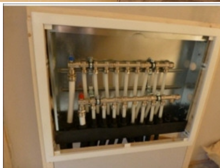
Fördelarna för kall- och varmvatten för hela huset sitter i toaletterna i herrarnas (vänstra bilden) och damernas (högra bilden) omklädningsrum. De kommer att döljas av en vitmaljerad lucka.
