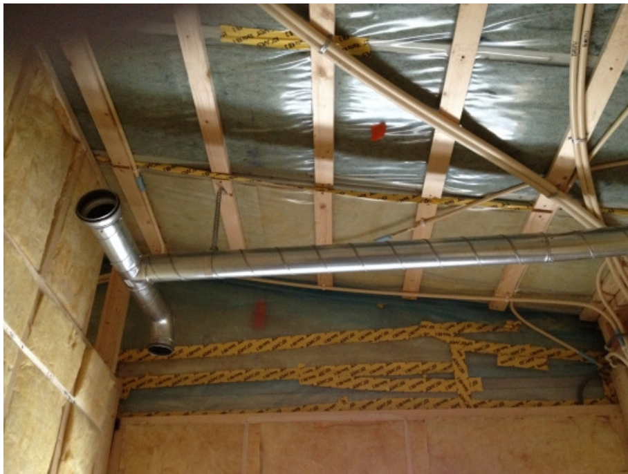
2014-07-03 Första ventilationsrören på plats, dessa går till teknikrummet och dambastun.
