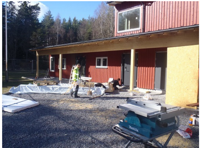
2014-03-23 WWL på plats igen. Denna gång på blixitvisit men monterade samtliga ytterdörrar och fönster. Nu är skalet tätt!
