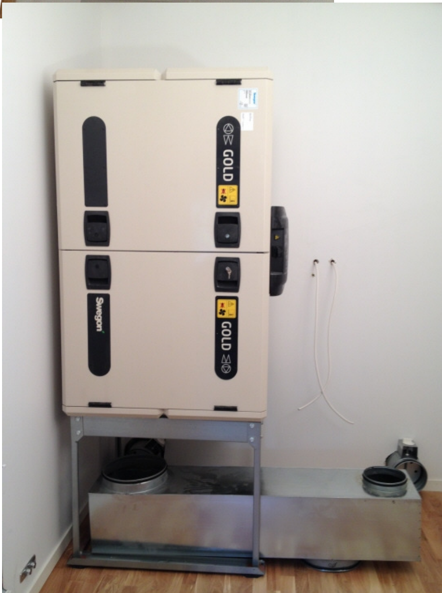
2014-09-20 Idag har det tagits ett stort steg närmare en delbesiktning av stugan då Tommy L, Johan K, Micke J, Janne M, B-O, Hans och Roland med gemensamma krafter lyft ventilationsaggregatet på plats.
