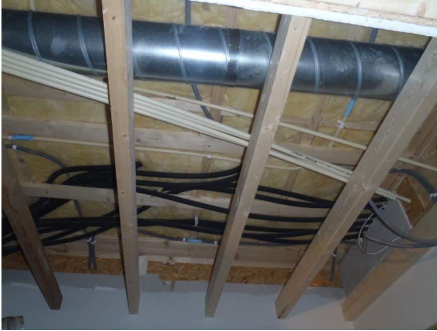
2014-10-28 Micke och Per har under kvällen dragit klart all el i taket i herrarnas skorum. Återstår bara burk för armaturen.
