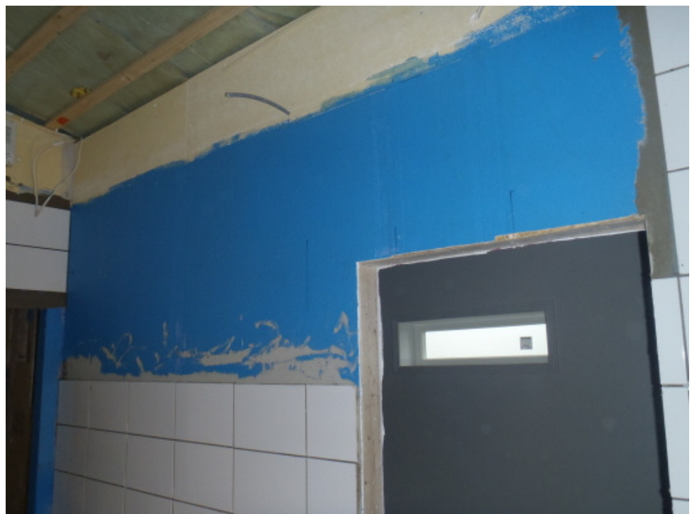
2014-08-30 Så här lite återstår innan all kakling är klar i damernas duschrum
