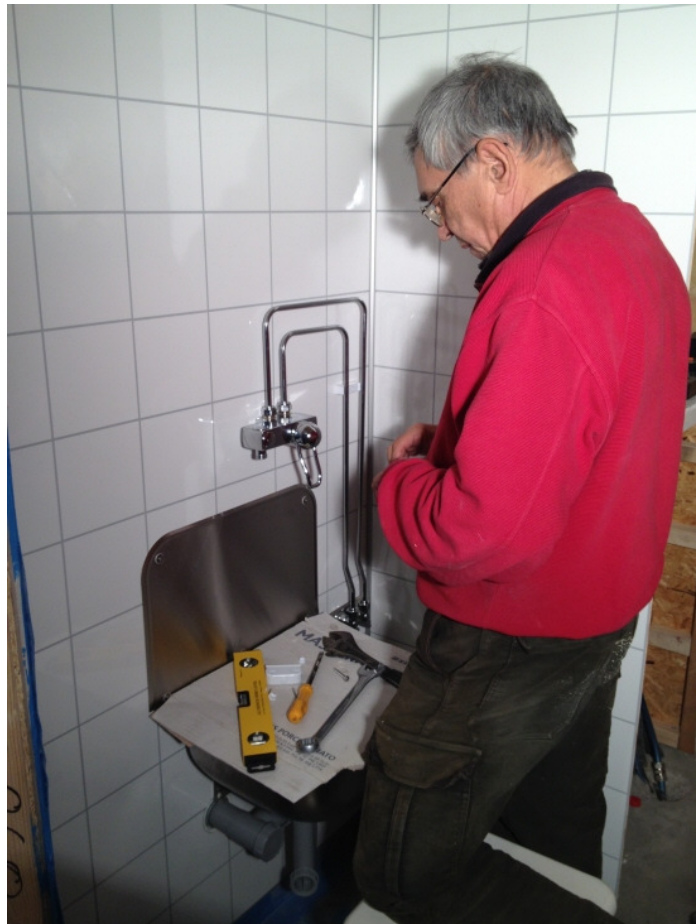
2014-11-25 Hans monterar vattenrör till kran i städskrubben
