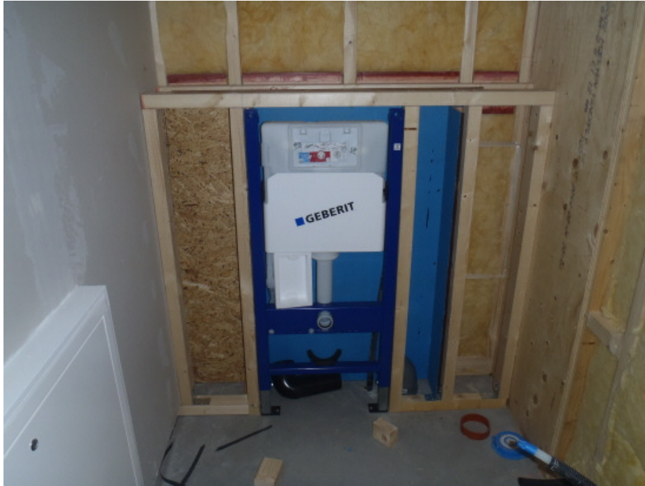
2014-09-24 Monteringen av toaletterna i omklädningsrummen går vidare
