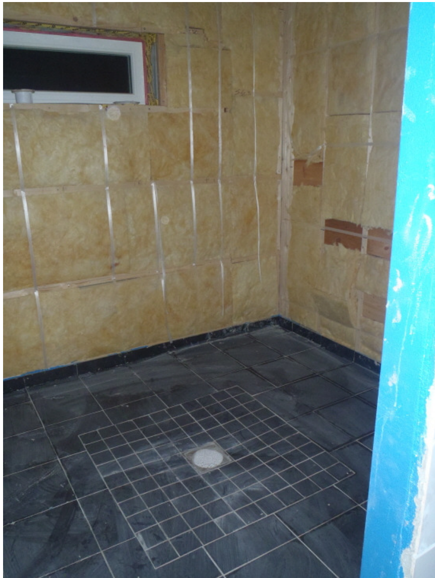
2014-10-28 Herrbastuns golv klinkrat och klart, återstår fogning (och lite klinkertvätt)
