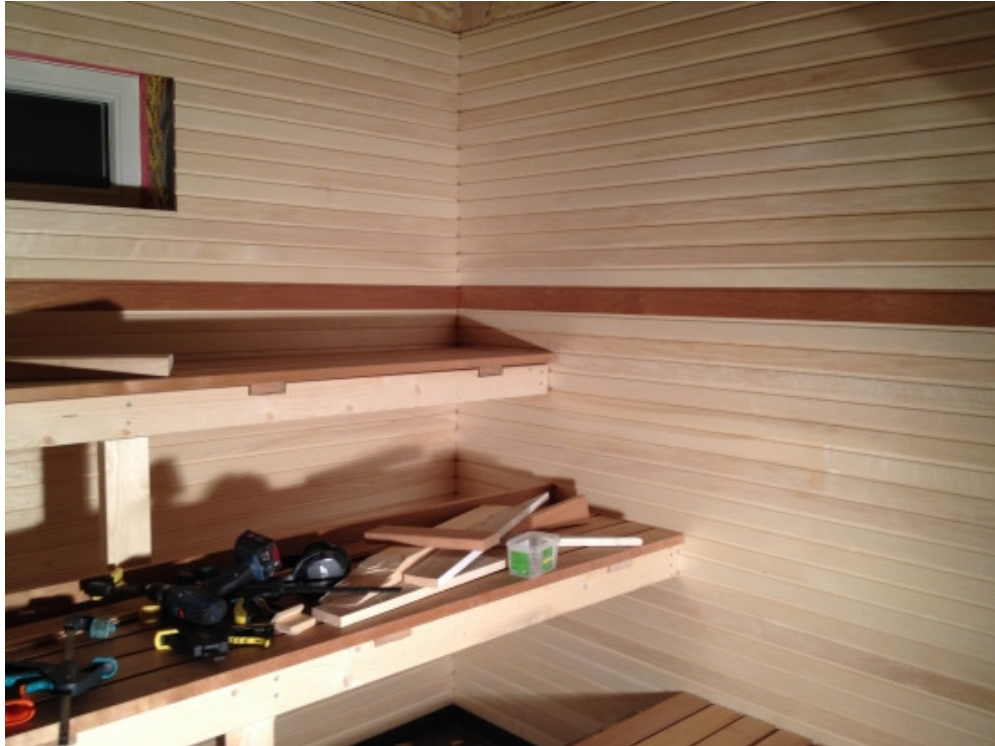
2014-11-25 Bastubyggandet börjar närma sig slutfasen
