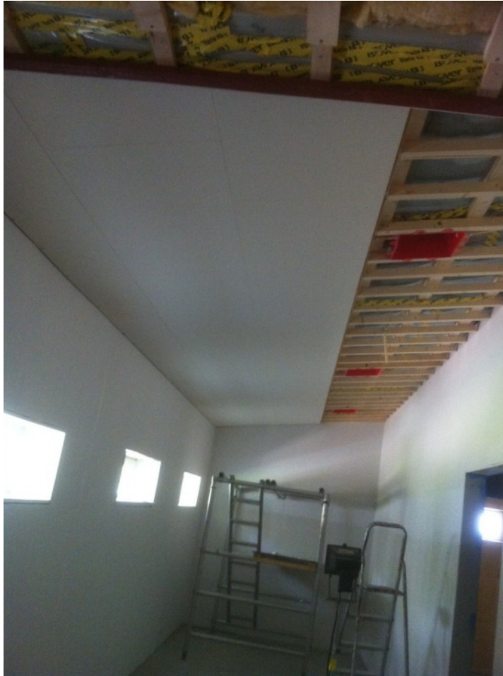
2014-07-02 Montering av takskivor har startat. Dessa har B-O och Uffe satt upp i herrarnas omklädningsrum
