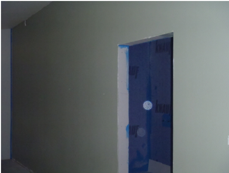
2014-08-10 Målning av omklädnings- rummen pågår för fullt. Här är en fondvägg i herrarnas omklädningsrum
