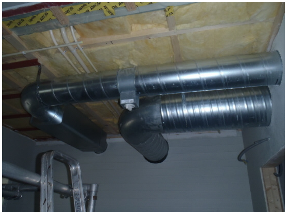
2014-08-10 Ventilationstrummorna är nu på plats i hela dusch- och omklädningsdelen. Här ser vi några i taket på damernas omkläd- ningsrum. De kommer inte att synas när vi är klara då ett innertak kommer att dölja dessa.
