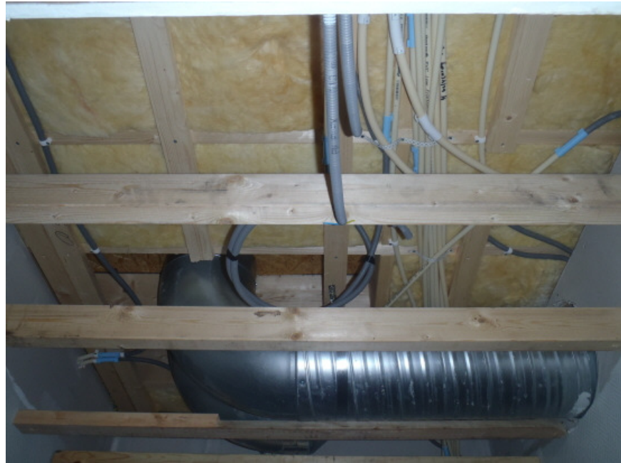
2014-10-28 Damernas skorum är också i det närmast klart. Återstår även här burk för armatur och lite justeringar av ventilationstrummorna
