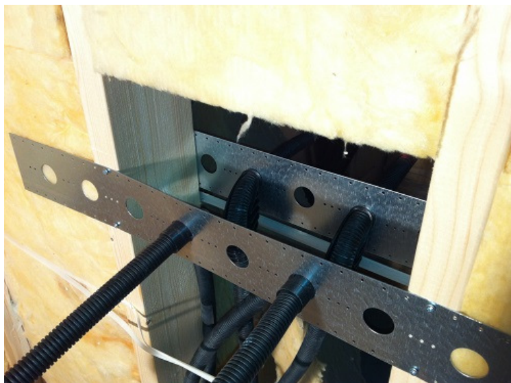
2014-04-05 Vattenrören monteras hela hela vägen för att uppfylla Säker vatten installation. Plåtarna ger automatiskt 160 c/c för att passa till duschblandaren.
