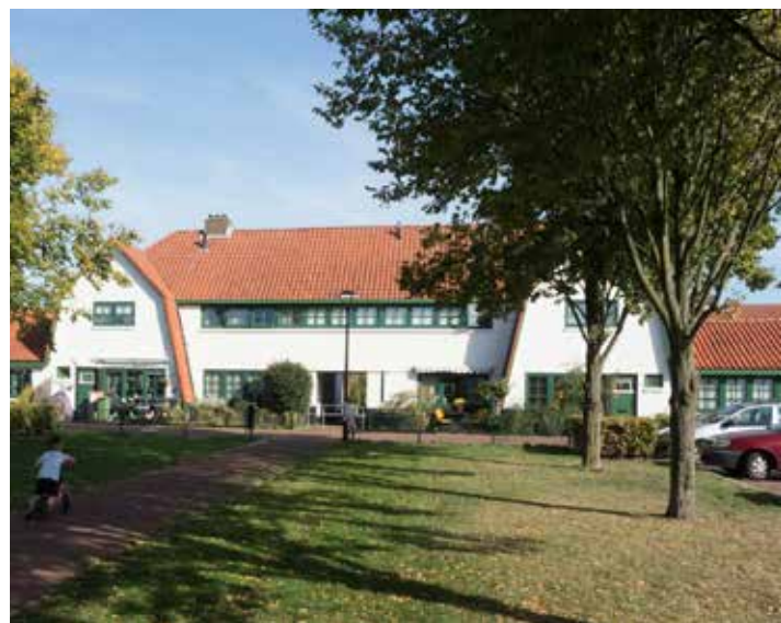
Edisonplein, een eeuw geleden ontworpen en gebouwd door Dudok, als eerste arbeiderswijk in de wijk over het spoor.
