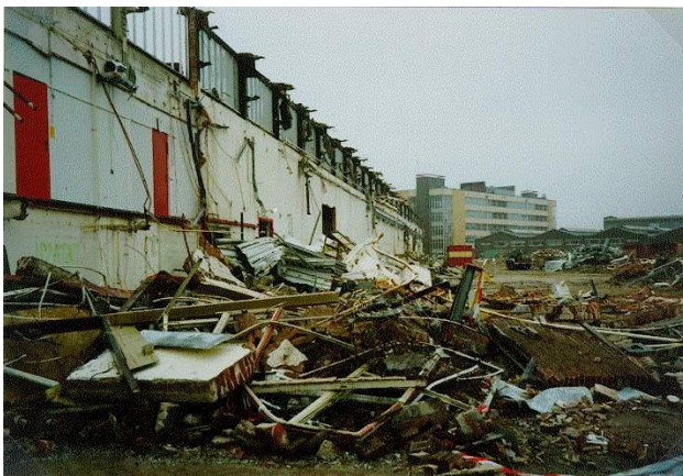
Foto van de sloop van de NSF gebouwen op het seinhorstterrein (Collectie Hilversum).
