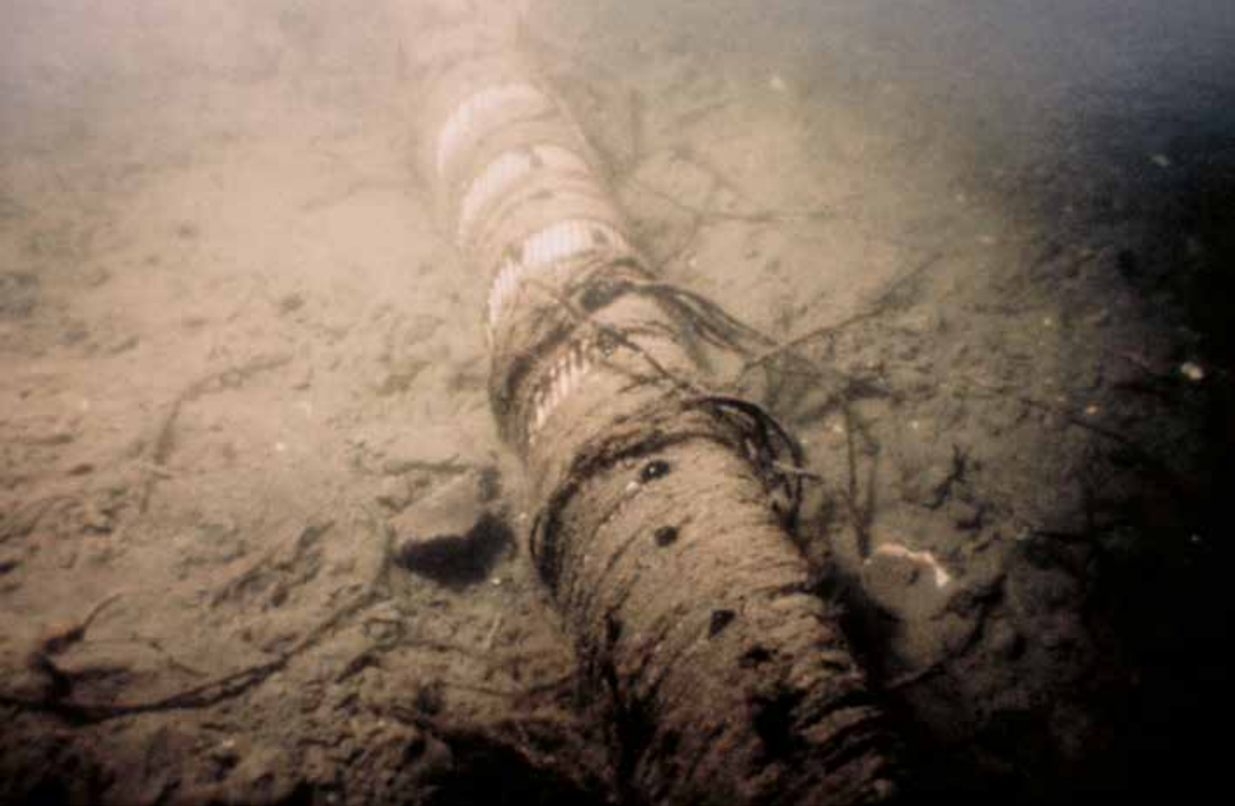
Fotot visar kabeln med oljedroppar som det såg ut vid vår inspektion. Foto: Sydkraft.
