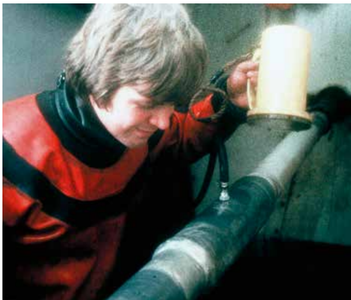
Dykaren Jan-Erik Johansson i habitatet med den reparerade kabeln. Foto: Sydkraft.
