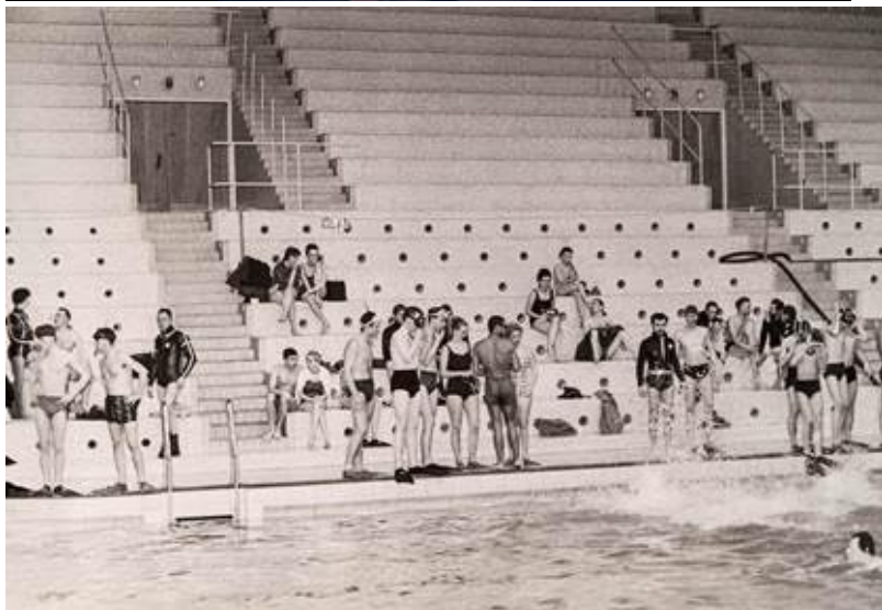
Renströmska Bad- och Tvättanstalten. Stig Danielsson.
