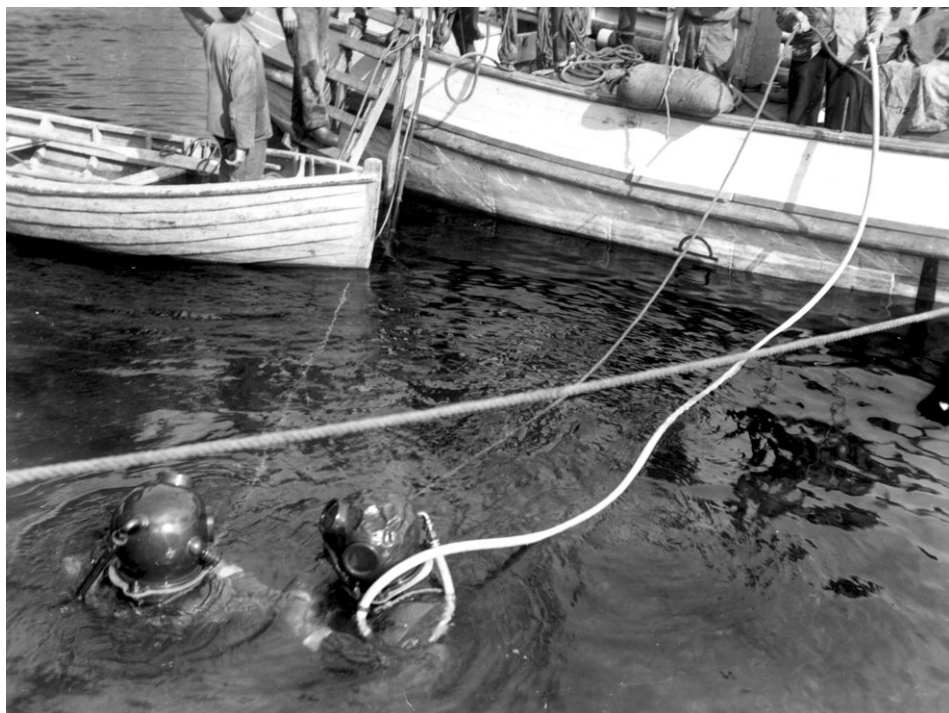
Billede fra bygning af Christian X bro i Sønderborg viser en dykker med en slange, der synker og en med en slange, der flyder. (Willy Jespens samling)
