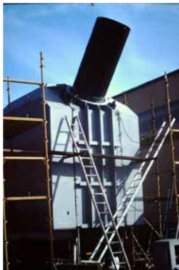
Uprøving av sveisehabitatet på en mock-up av staget på Stoltenberg (Foto JP Marshall).
