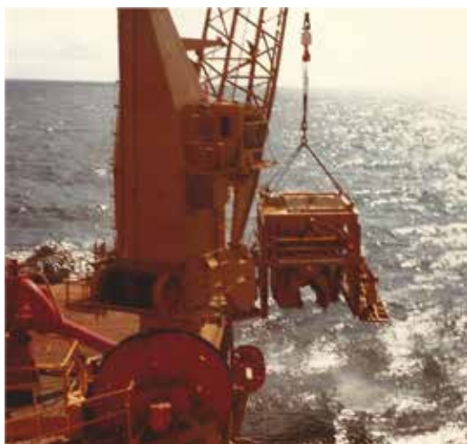
Hyperbar sveiset reparasjon av Stolt-Nielsen Seaway til AMOCO Valhall.
