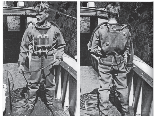
Bilde 40. Ove Lund med det slangeforsynte blandingsgassapparatet, forfra og bakfra. © Bjørn Bjørne
