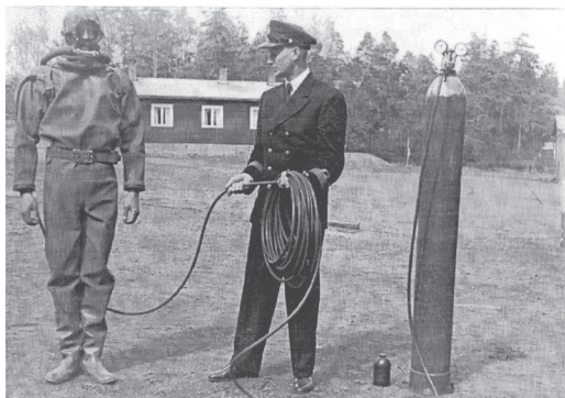
Ove Lund demonstrerer «Narghile» slangeforsynt pusteutstyr Dräger Modell PA 60/S. Foto DFS
