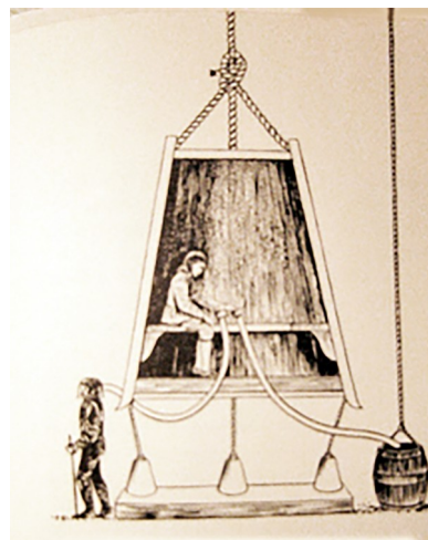
Halleys dykarklocka som kom omkring 1690 (Ur Bo Cassels bok, Havet Dykaren Fynden)
