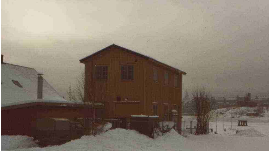
Dyktankhuset i vinterskrud 13 februari 1979.
