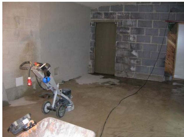
Gavelväggen i väntan på nya entrédörren
