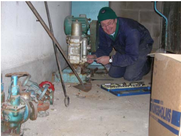
Matarvattenpumpen monteras bort
