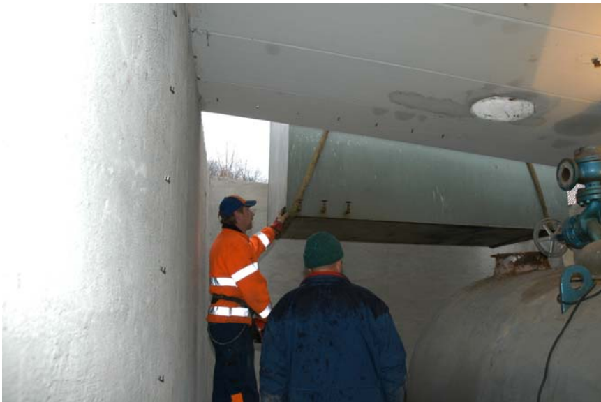
Janne från Haninge Åkeri, som hyrts in av BinSell för jobbet, lyfter här brännoljetanken efter att skorsten och några takbalkar flyttats.
