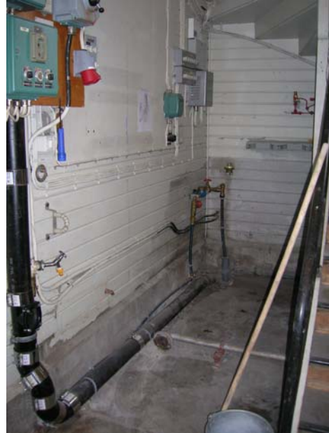
Här har avloppet sänkts men elarbeten återstår
