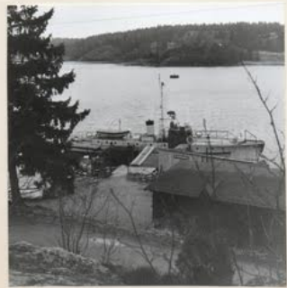
"M/S KANHOLMSFJÄRD" LIPPSTÄLLNINGSPLATSEN KANOTHUSET OCH KOMPRESSORHUSET.
