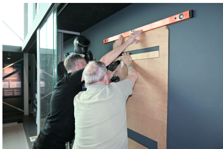
De store plancher ophænges efter en skabelon
