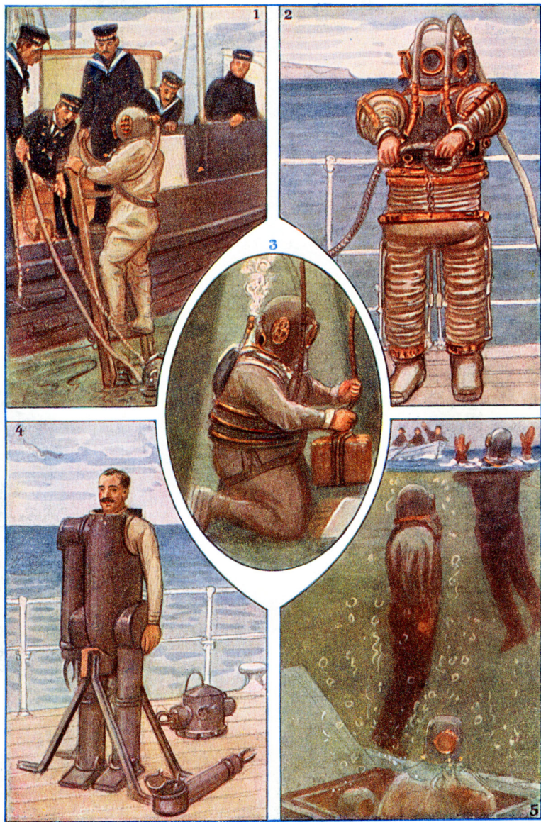
1. Dykker gaar ned paa lavt Vand. 2. Dykkerudrustning til større Dybder. 3. Dykker i Virksomhed paa Havbunden. 4. Dykkerudrustning til Dybhavsdykning. 5. Besætningen fra en sunken Undervandsbaad redder sig ved Hjælp af Dykkerhjelme og Dragt med indpumpet Luft.
