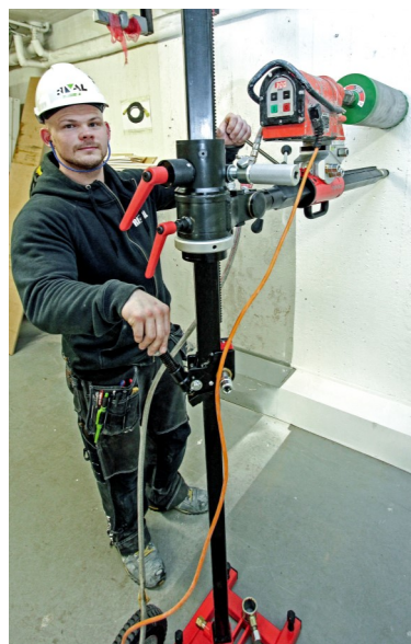
Horisontell borring med 50 + stämpstativ, maskinfäste Weka och Weka SR bormaskin.
