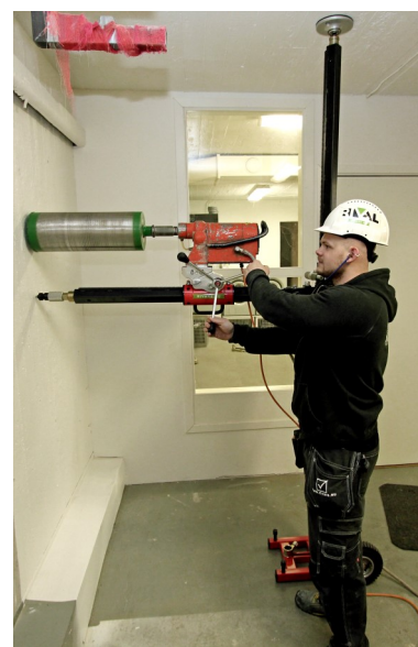
Horisontell borring med 50 + stämpstativ, maskinfäste Weka och Weka SR bormaskin.
