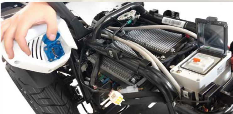
Trasformatore 220 V con protezione salvavita
