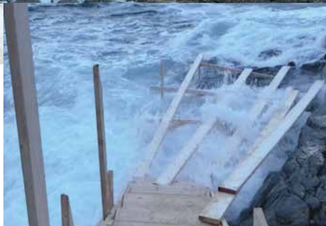
I Strömstad fick teamet bygga en brygga två gånger på grund av lynnigt väder.
