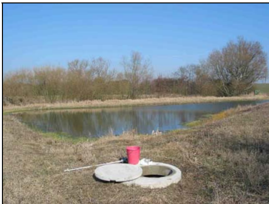
Utløpsbrunnen ved øvre dammen. Utløpsstrøskelns nivå kan reguleres med hjelp av plankor i utløpsbrunnen.
