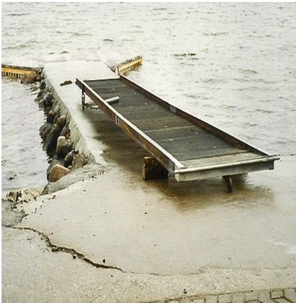
Gammel rampe repareret for genbrug ved nye flydebroer 2004
