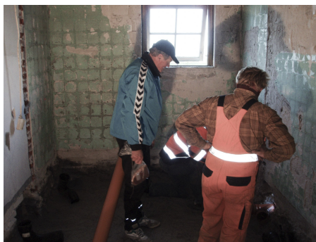
Der graves dybt ned under gulvet i baderummet
