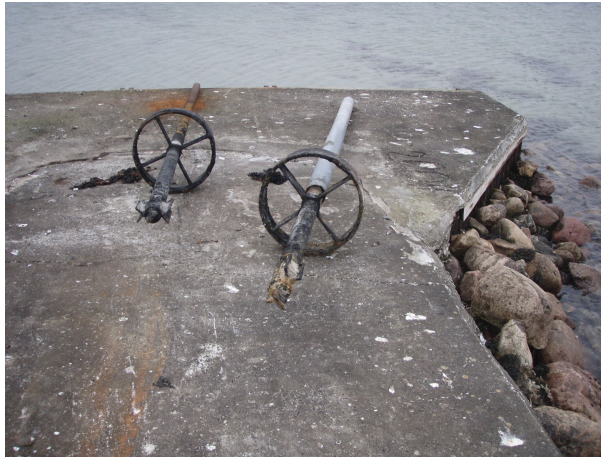
De to stålpæle med havbundsøsning på land for eftersyn og reparation 2009
