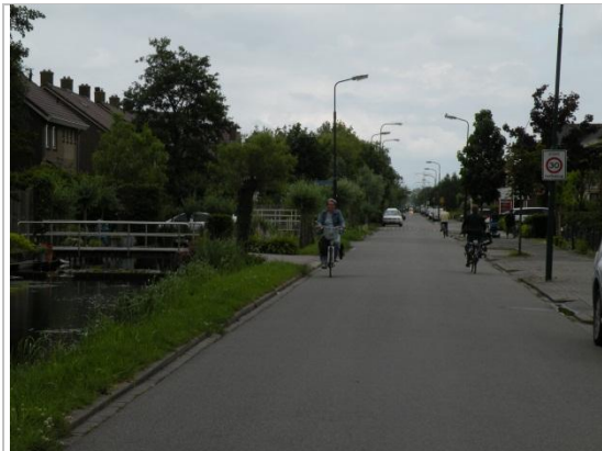
Geen passende boombeplanting (soort en standplaats) langs Kerkweg, Kockengen.
