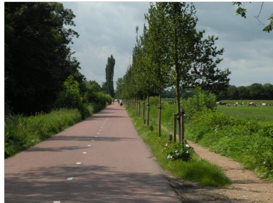
Versterken van lanen in overgang oeverwalplasseengebied.
