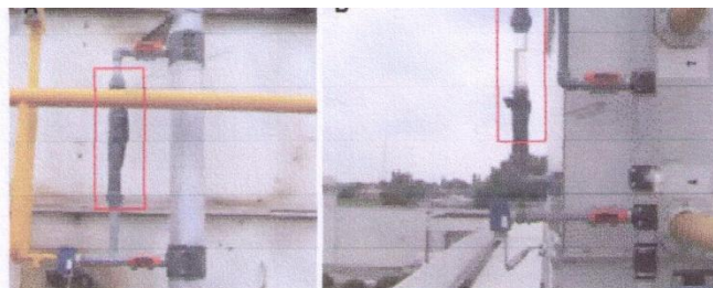
Figuur 1: Plaatsing biofilmmonitoren (rood omkaderd) op de koeltoren KT1 (A) en koeltoren KT3 (B). Hierbij werd de biofilmmonitor telkens in bypass aangebracht, net voor de ingang in de condensor van de koeltoren. Deze monitor bestond uit een doorzichtige buis waarin 30 polycarbonaat ringen geplaatst werden.
