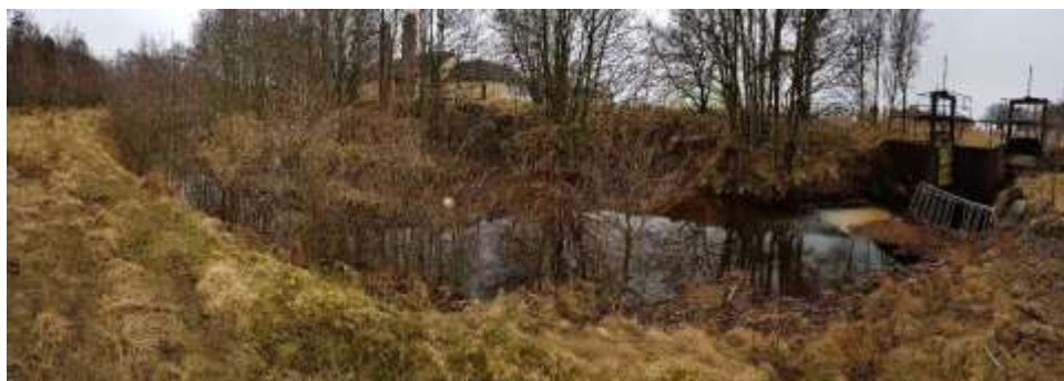
Figur 28 Inntak for Kanal A1 og B1 samt bekkeleie oppstrøms. Foto: Sweco
