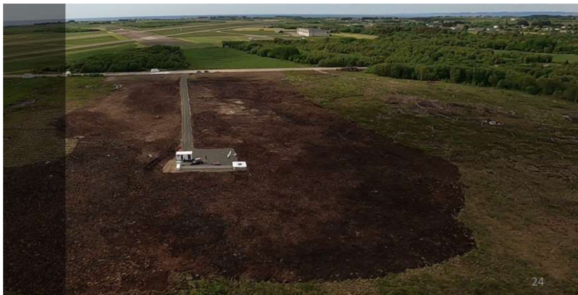
Figur 10 Oppsett av kjeturbiner. Inngrepet består av bygging av veg og snuplass, samt fjerning av vegetasjon og røtter i et stort område rundt. Kilde: Kitemill
