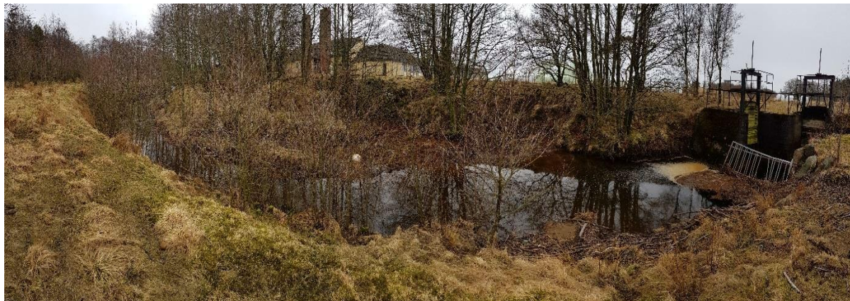
Figur 29 Inntak for Kanal A1 og B1 samt bekkeleie oppstrøms. Kilde: Sweco
