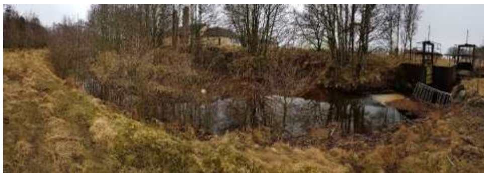
Figur 27 Inntak for Kanal A1 og B1 samt bekkeleie oppstrøms. Kilde: Sweco
