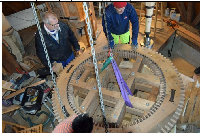
Hjulet, klar til at modtage sin stående aksel
