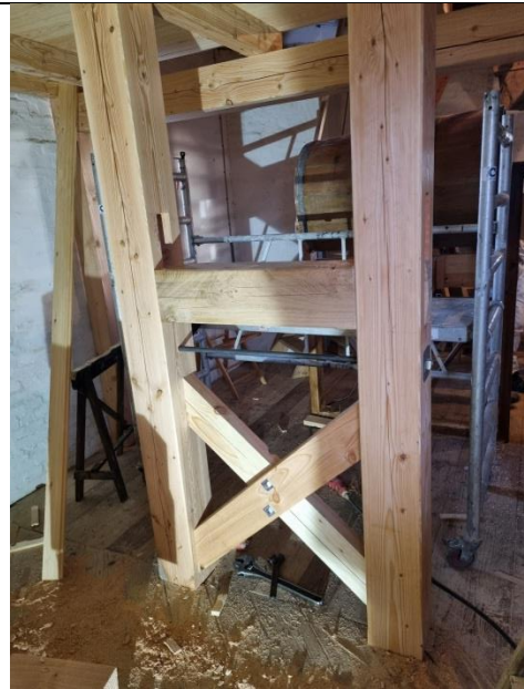
Det nye broværk og grubbe under montering
