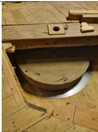
Kværnstenen på plads i grubben
