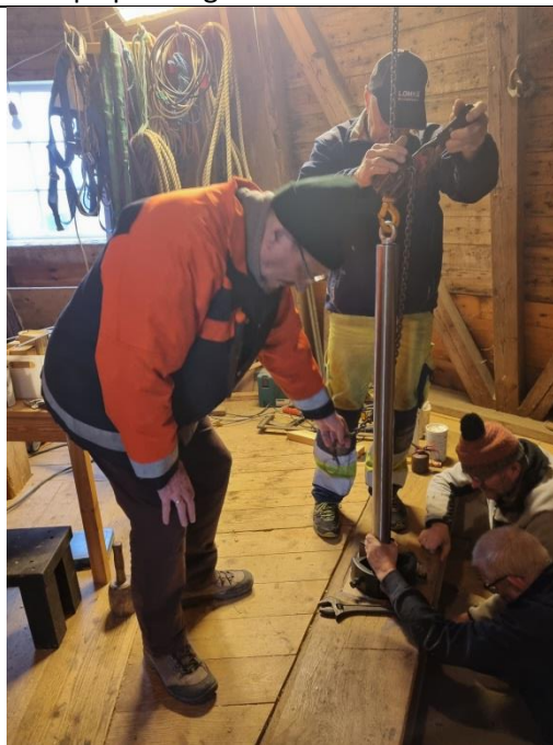
Bosset og langjern bliver monteret i halsbjælken og stenen
