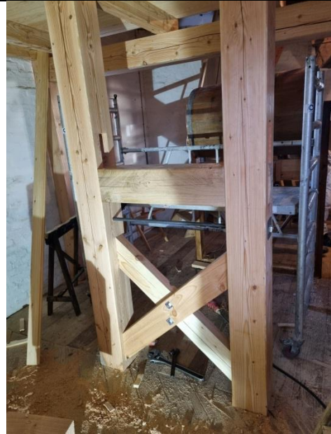
Det nye broværet og grube under montering
