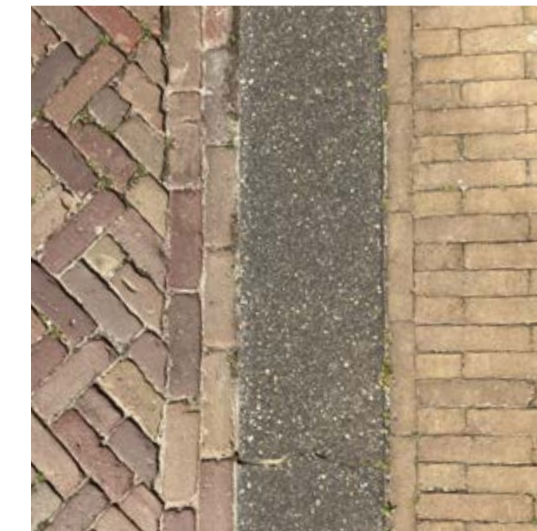
Huidige bestrating rijbaan-trottoirband-trottoir in Andringastrjitte.
