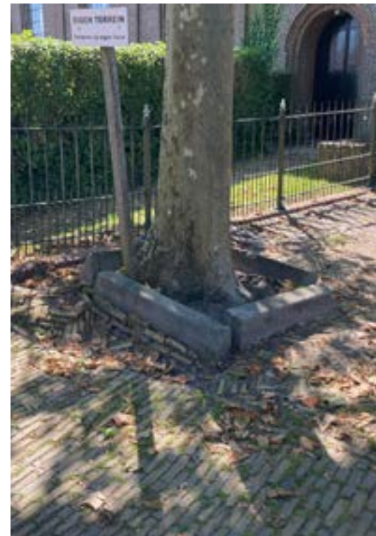
Eén van de platanen op het kerkplein.
