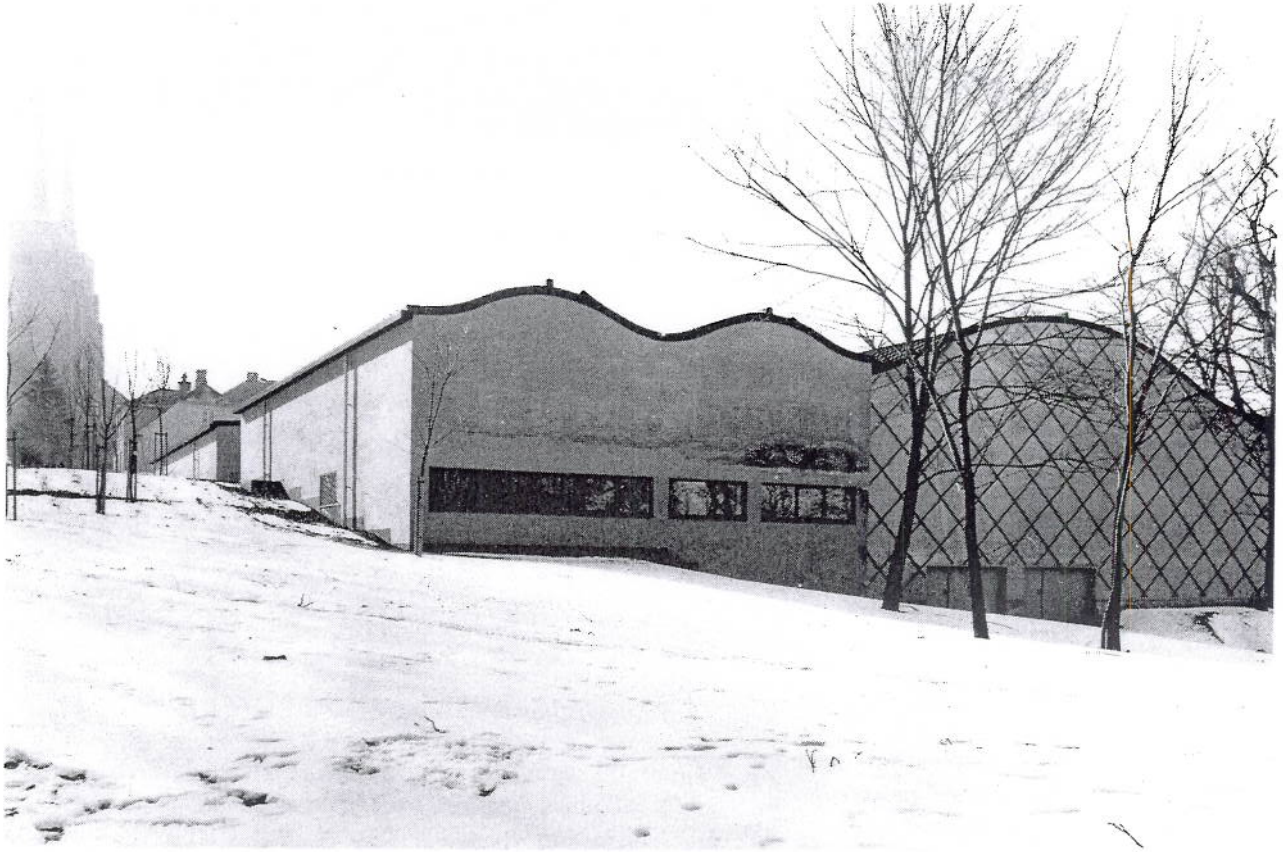
Det nyopførte »gymhus« på Fjordvillas gamle grund.
