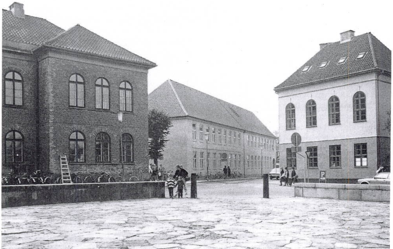
Bondetingets nyopførte kalkede og vandskurede bygninger i arkitektonisk samvirke med den gamle hovedbygning.
