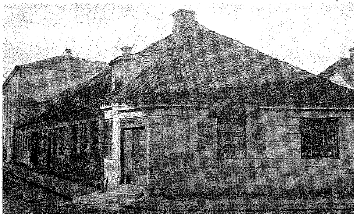
Hjørnet af Bondetinget og Skolegade, hvor Roskilde kongsgård i svundne tider lå. Det gamle hus på billedet blev nedrevet 1920 for at give plads for katedralskolens nye gymnastikbygning.
