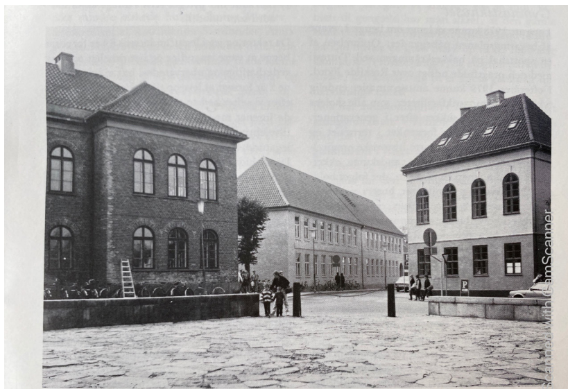
Bondetingets nyopførte kalkede og vandskurede bygninger i arkitektonisk samvirke med den gamle hovedbygning.
