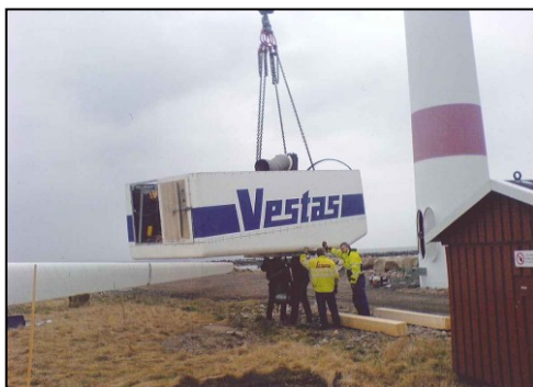
Nedmontering av generatorhus (Källa: Consortis)
