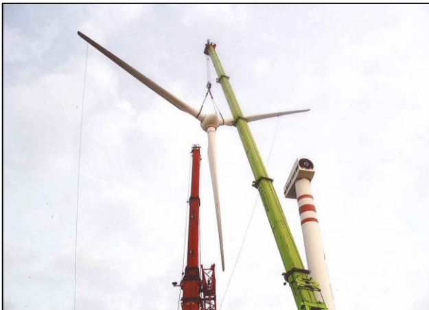
Nedmontering av rotor (Källa: Consortis)
