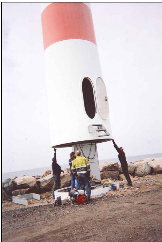
Nedmontering av torn (Källa: Consortis)
