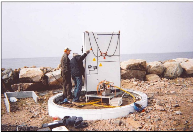
Fundamentkrage m.m (Källa: Consortis)
