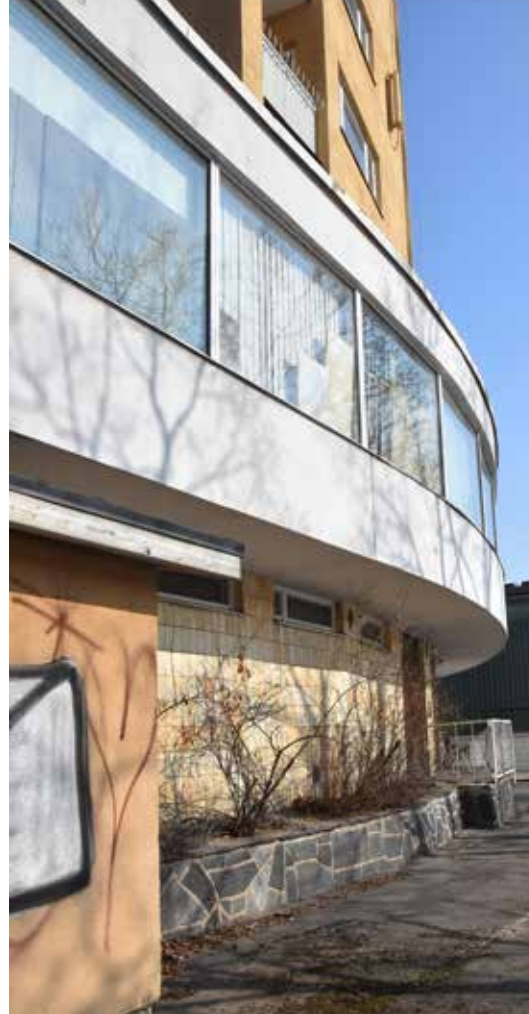
Vanha ruokalaosa näkyy julkisivussa erkkerimäisenä kaarena.
