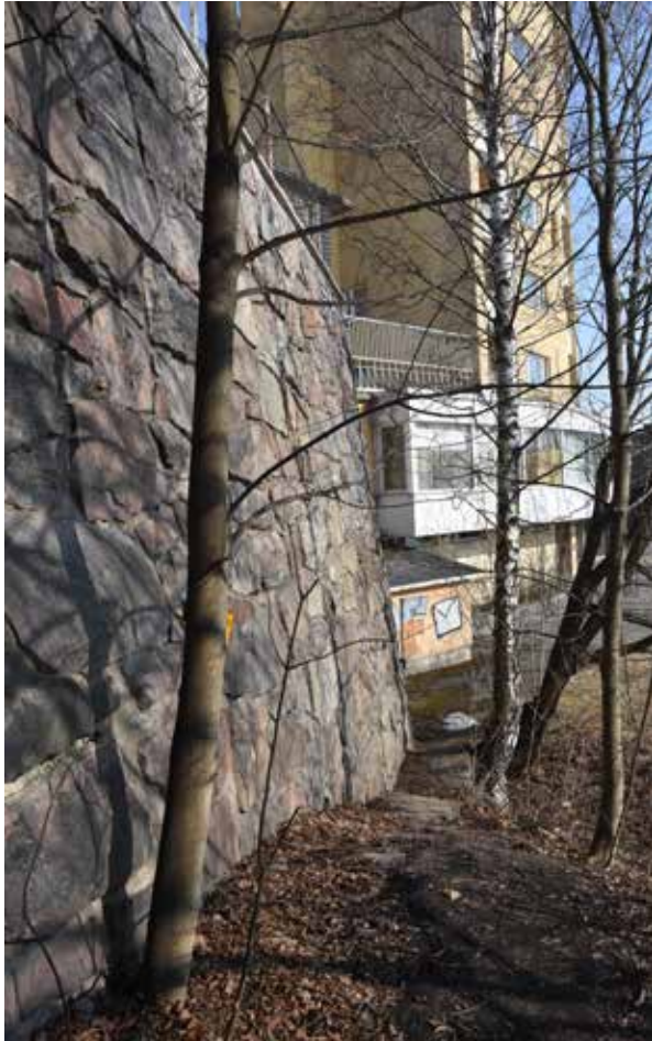
Rakennukseen D liittyy kiinteästi myös kivimuurin, joka jakaa linja-autopihan ja 7 metriä alempana olevan raitiovaunupihan.
