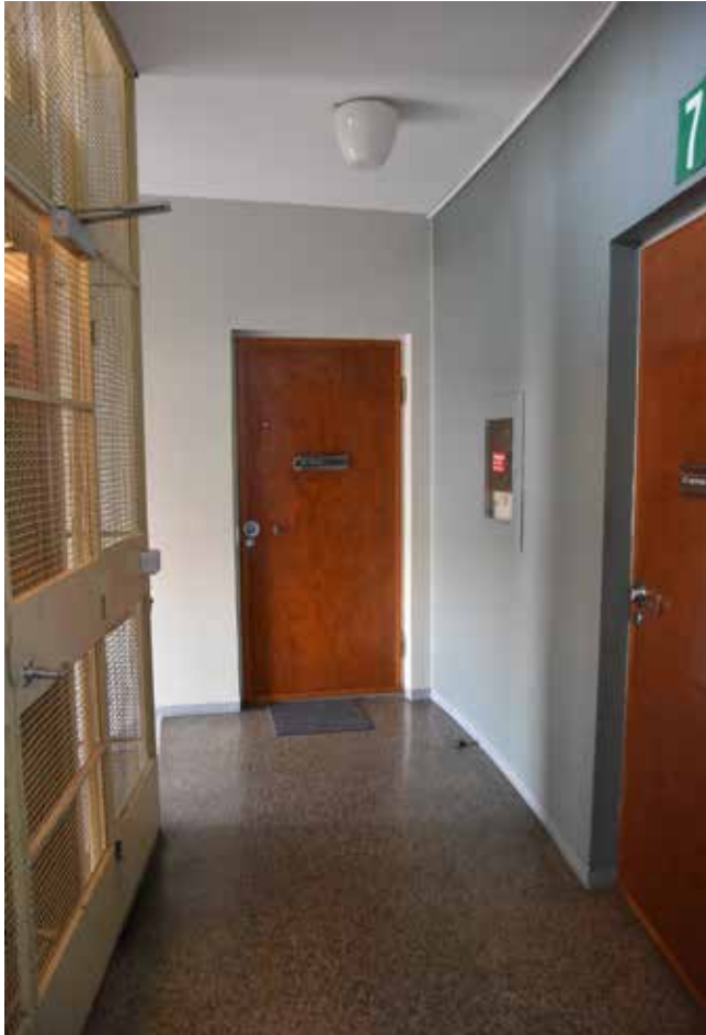
D-rakennuksen rappukäytävä. Lattia, huoneisto-ovet heloineen ja hissi ovat alkuperäisiä.
