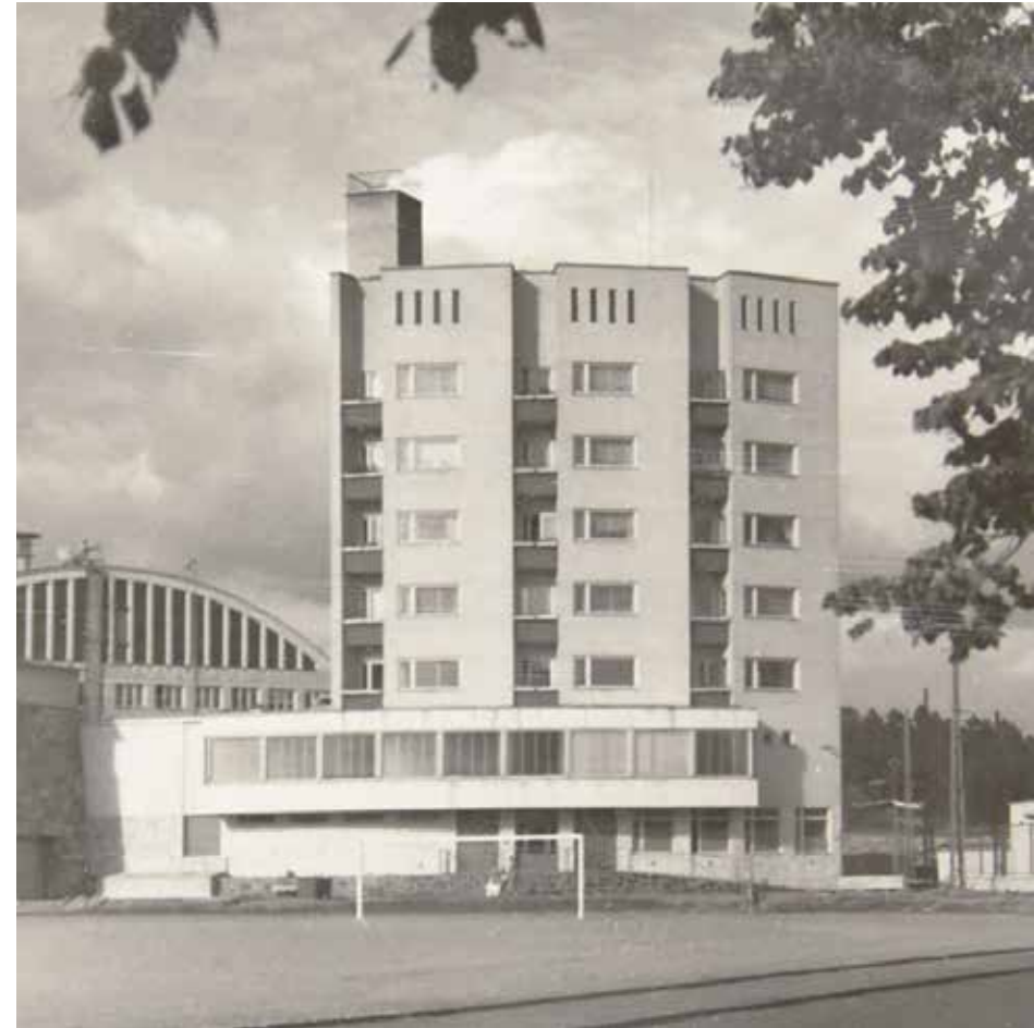
Keskusrakennus D Annalan kentän suunnalta kuvattuna pian valmistumisen jälkeen. Osakuva Havas, HKM, reprokuva Sanna Ihatsu.
