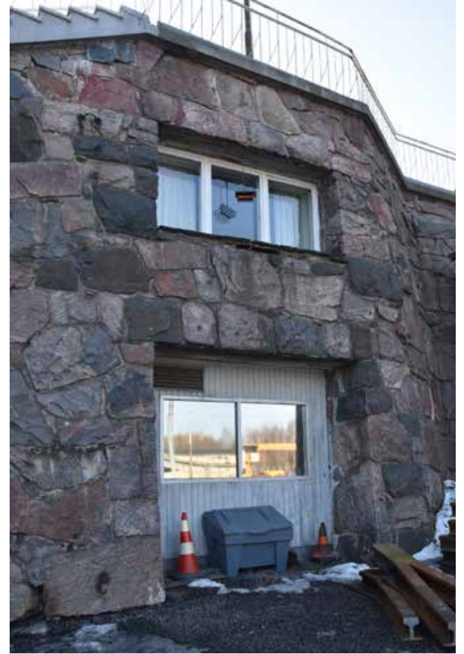
Kiinteistöhuollon tiloja on D-osassa, kivimuurin sisällä.
