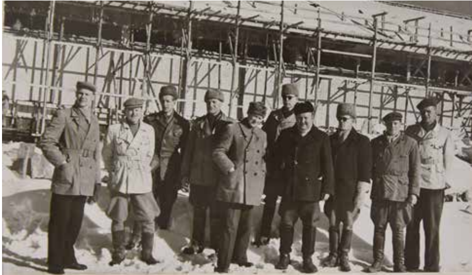
Constructorin rakennustyöläisiä Koskelan työmaalla, Foto Roos 19.3.1952, HKM reprokuva Sanna Ihatsu.
