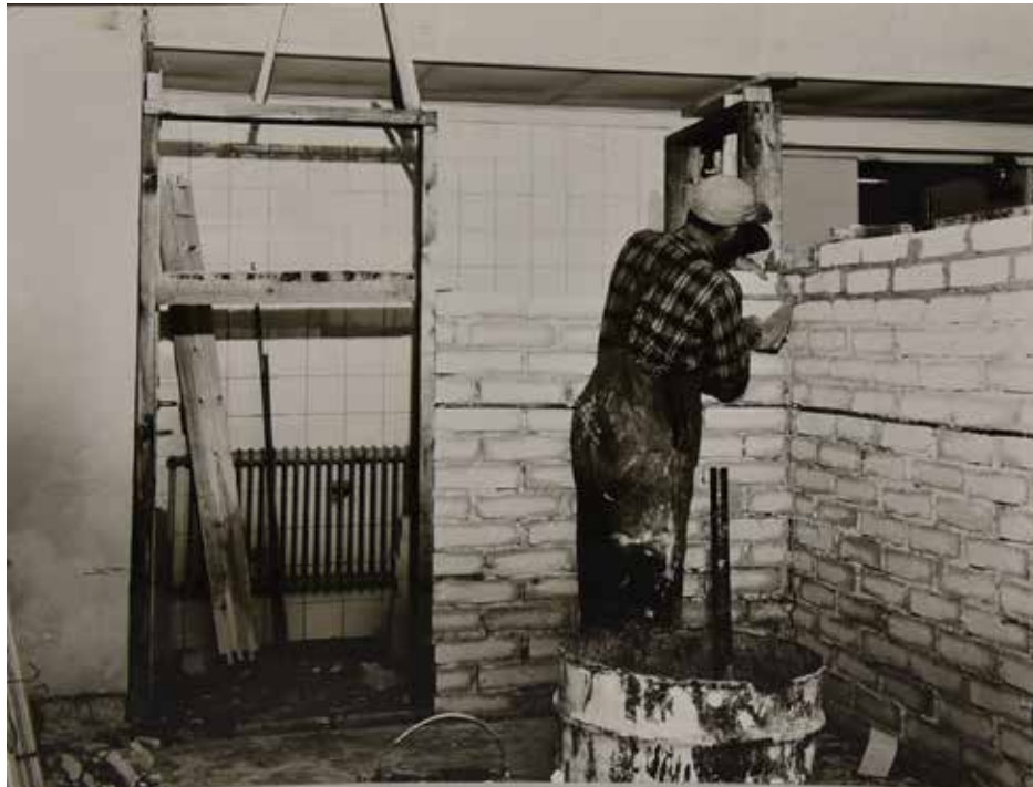
Raitiovaunuhuollon saunan rakennustyöt käynnissä. Kuva Valtonen 7.9.1967, HKM, reprokuva Sanna Ihtsu.
