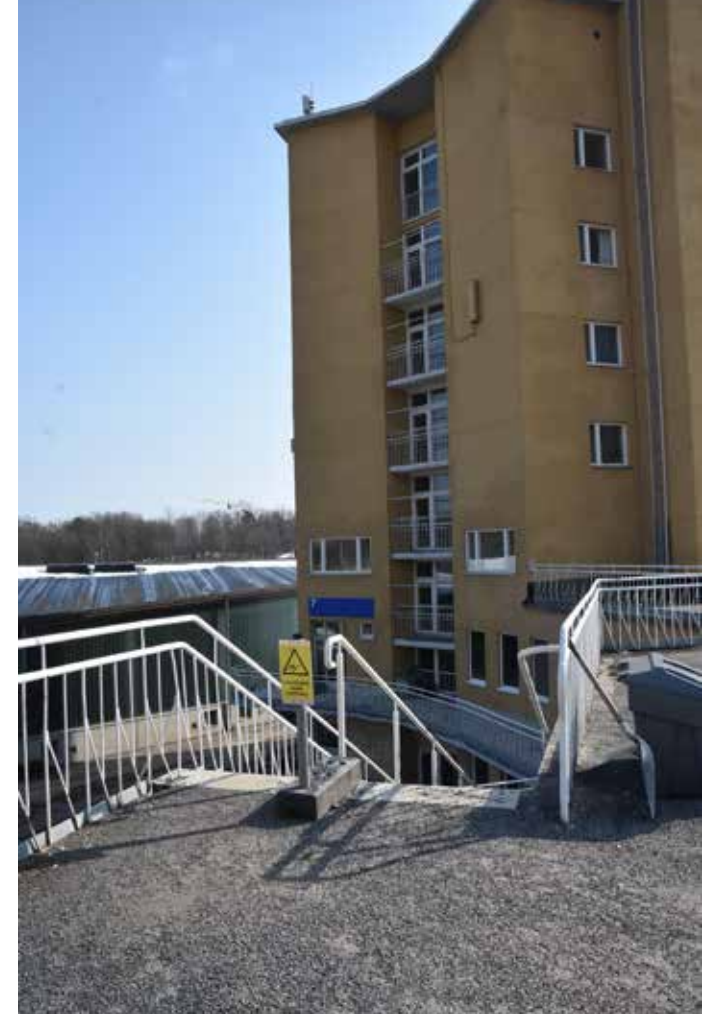
Rakennukseen oleellisesti liittyvät kaiteet ja terassit ovat säilyneet. Keskellä portaikkoa oleva kaide on lisätty myöhemmin.
