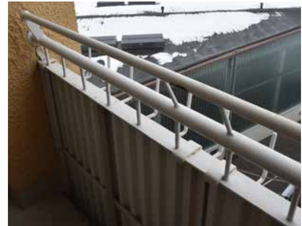
D-rakennuksen parvekkeiden kaiteita on korotettu myöhemmin.
