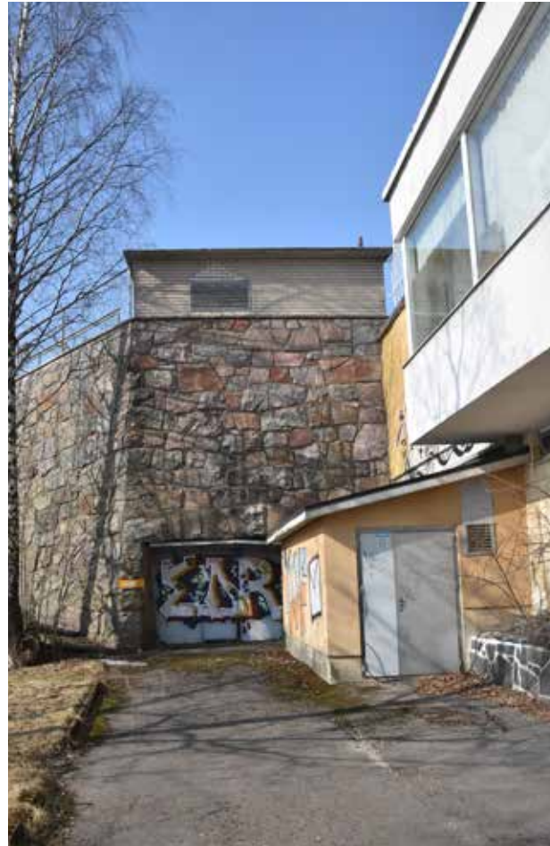
Kivimuurin sisällä on säilynyt tuhkanerotushuone, joka on liittynyt keskuslämmitykseen öljyllä. D-osan kylkeen rakennettu lämmönjakohuone on uudempi 1985 rakennettu osa.
