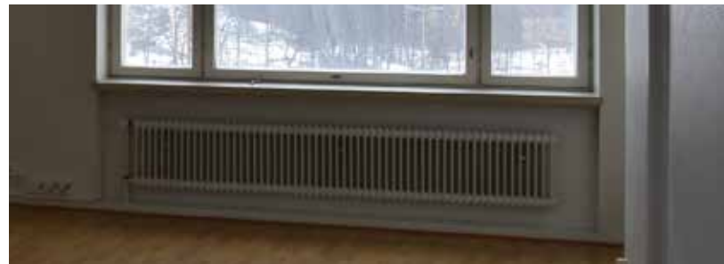
Alkuperäinen patteri ja ikkunapenkki asuinhuoneistossa.
