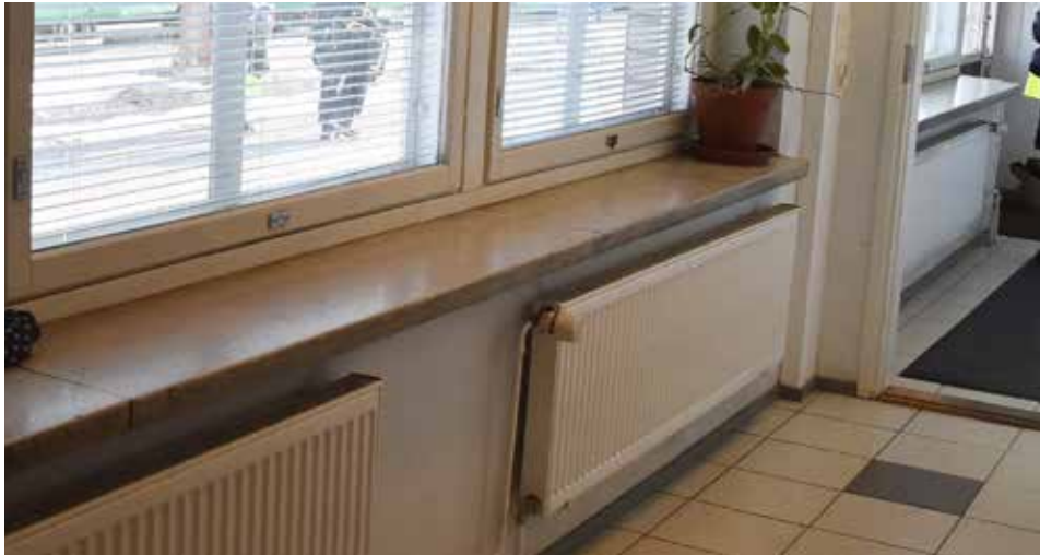
Säilynyt alkuperäinen valkomosaikkisementtinen ikkunapenkki B-hallissa.
