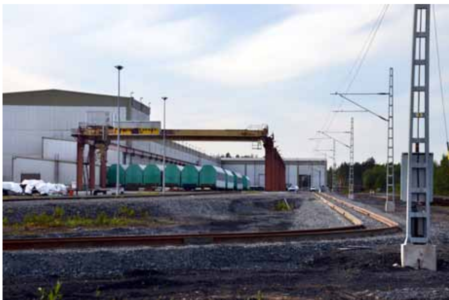
Otanmäkeen Transtechin tehtaalle on valmistunut koeajoraide uusia MLNRVIII-vaunuja varten. Radan ja sähköistyksen rakensi VR Track. Kuva Olavi Huotari 29.8.2012.
