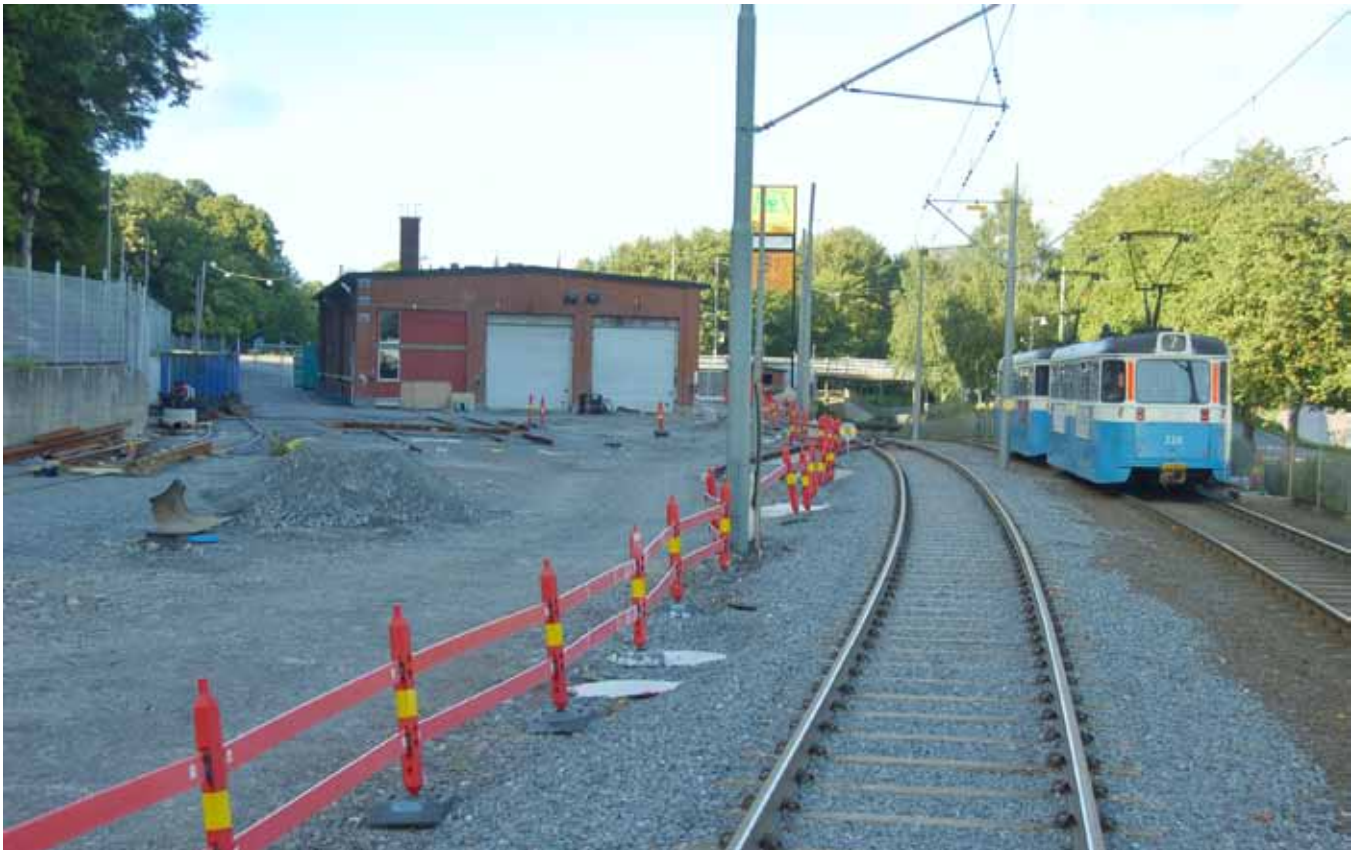
Yllä: Slottsskogenin uusi halli, jonka edustalla ratapihatyöt ovat meneillään. Kuvassa näkyy myös M28-vaunu 724 1960-luvun puolivälistä, kuvattu 7.9.2012.
