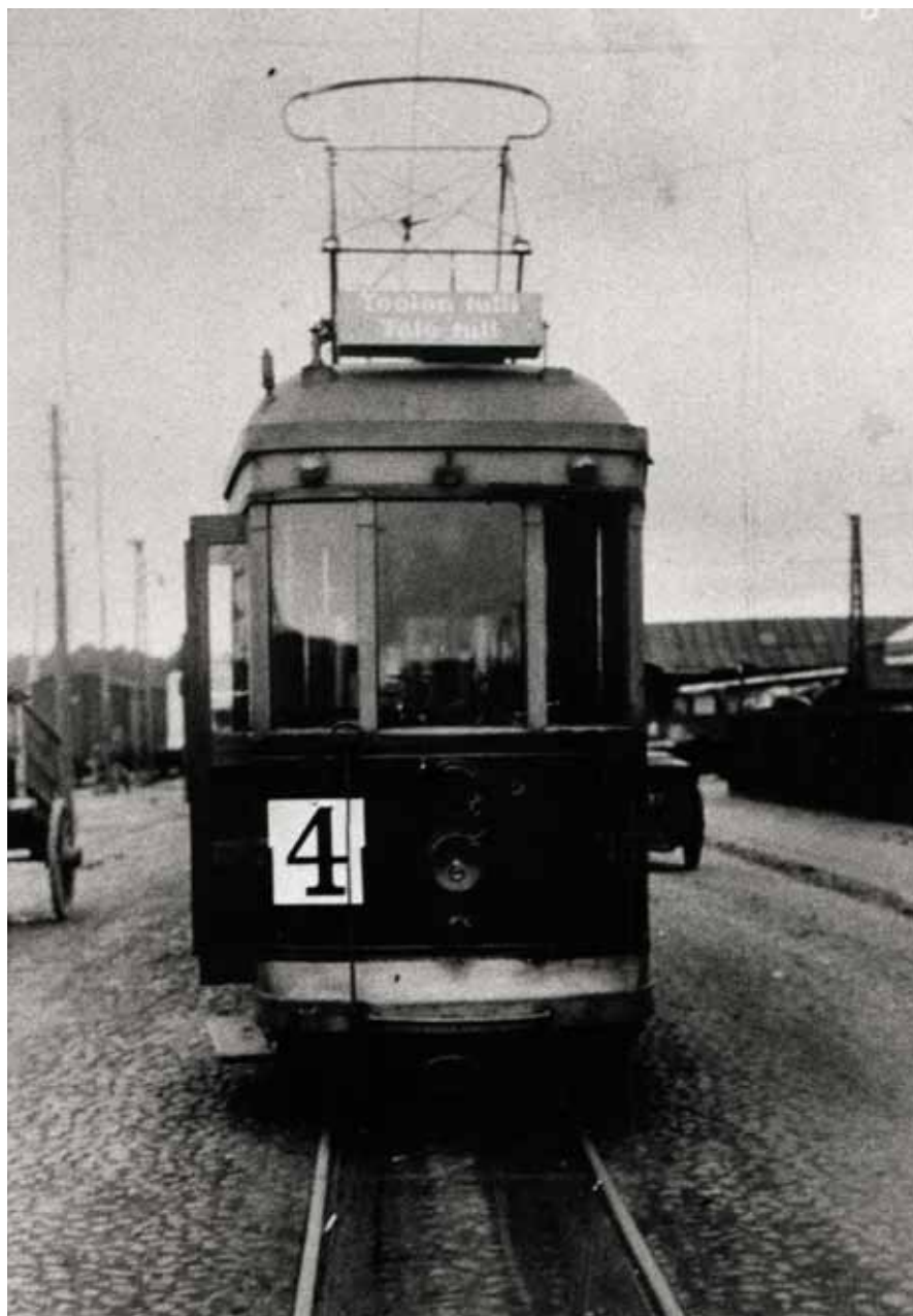
Saksalainen NWF-moottorivaunu nro 17x (ehkä jopa artikkelissa mainittu nro 175) 4-linjalla. Kuva on Ruoholahdenrannan päätepy-säkiltä 1930-luvun puolivälistä. Määränpäälki on jo käännetty "Töölön tullin" suuntaan. Vasemmalla on Valtionrautateiden Ruoholahden ratapihaa tavaravaunuineen. Kokoelma Jorma Rauhala
