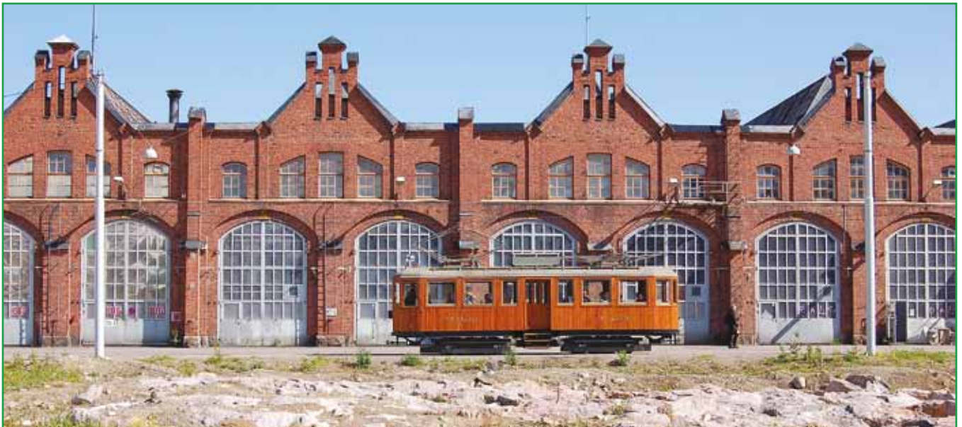
SRS:n kevätajelulla 30.5.2011 nautittiin Kulosaaren Jumbon kyydistä Käpylän, Itä-Pasilan, Vallilan, Alppilan ja Sörnäisten maisemissa. Vallilassa ohitetaan entistä yli sata vuotta vanhaa Pasilan rautatiekonepajan päätyä Traverssikujalla. Kuva Jorma Rauhala 30.5.2011.
