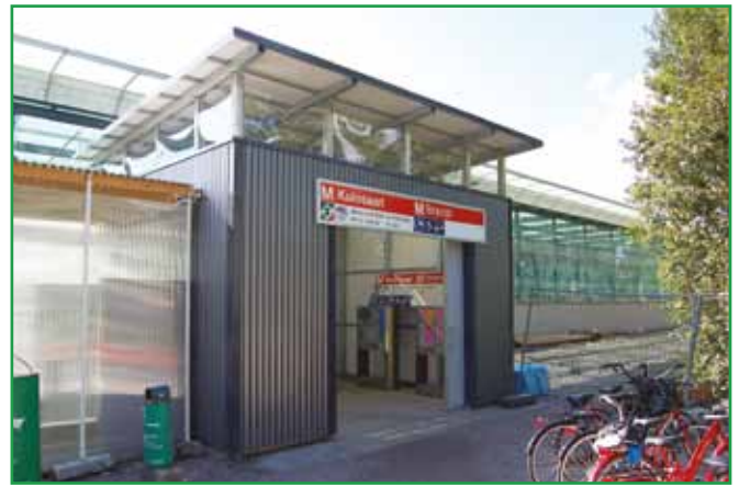
Kulosaaren aseman tilapäinen pääsisäänkäynti 24.8.2011. Kuva Jorma Rauhala
