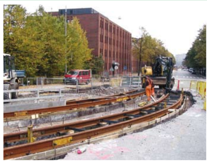
Ratatyöt Aleksis Kiven kadun ja Traverssikujan risteyksessä alkoivat syyskuun lopulla. Kuva Juhana Nordlund 29.9.2007, Helsinki.
