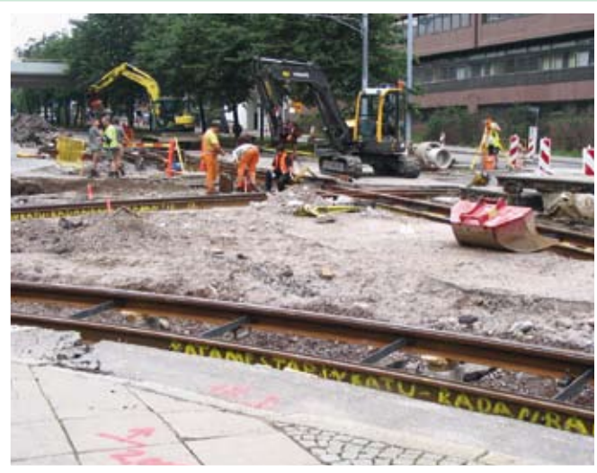
Töitä tehtiin ahkerasti elokuun jälkipuoliskolla Radanrakentajantien ja Ratamestarinkadun risteyskosen luona. Kuva Juhana Nordlund 23.8.2007.
