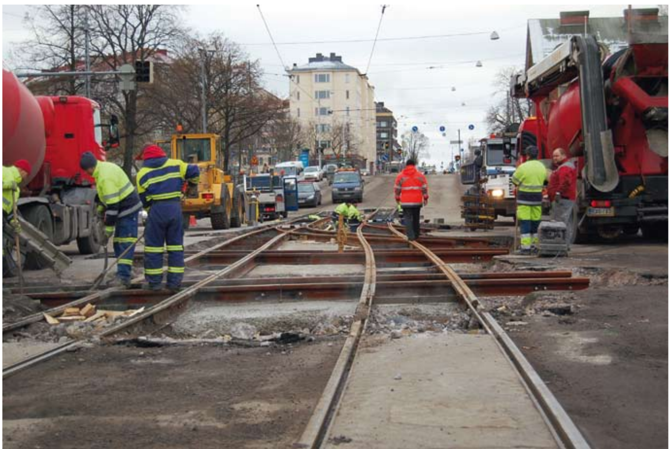
Viikonvaihteessa 16. - 19.11. (perjantai-illasta maanantaiaamuun) työt keskittyivät Aleksis Kiven kadun ja Sturenkadun risteykseen. Paikalle asennettiin ristikot ja uudet yhdysvaihteet Kallion suunnalta konepajan suunnalle. Kuva Juhana Nordlund 17.11.2007, Helsinki.
