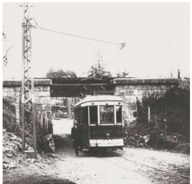
Kolmosen (3B) Jenkki-vaunu Nordenskiöldinkadun rautatiesillan alla vuonna 1922. Ratasilta on tässä vielä alkuperäinen 1800-lu-vulta peräisin oleva ja raitiotie on sillan kohdalla yksiraiteinen. Ku-vanoton aikaan Pasilan asema sijaitsi nykyisessä Länsi-Pasilassa "Toralinna" lähellä. Kuva kokoelma Jorma Rauhala.
