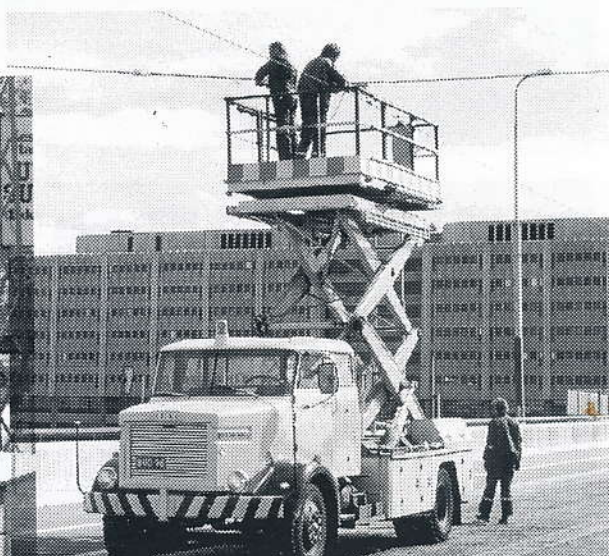
▲ Kontio-Sisu LP-138 BIT/4400 -torniauto 1504 (BUD-96) vuodelta 1971 Pasilansillalla linjan 7 ajojohtojen viritystyössä 7.6.1985. Kuva Jorma Rauhala.
