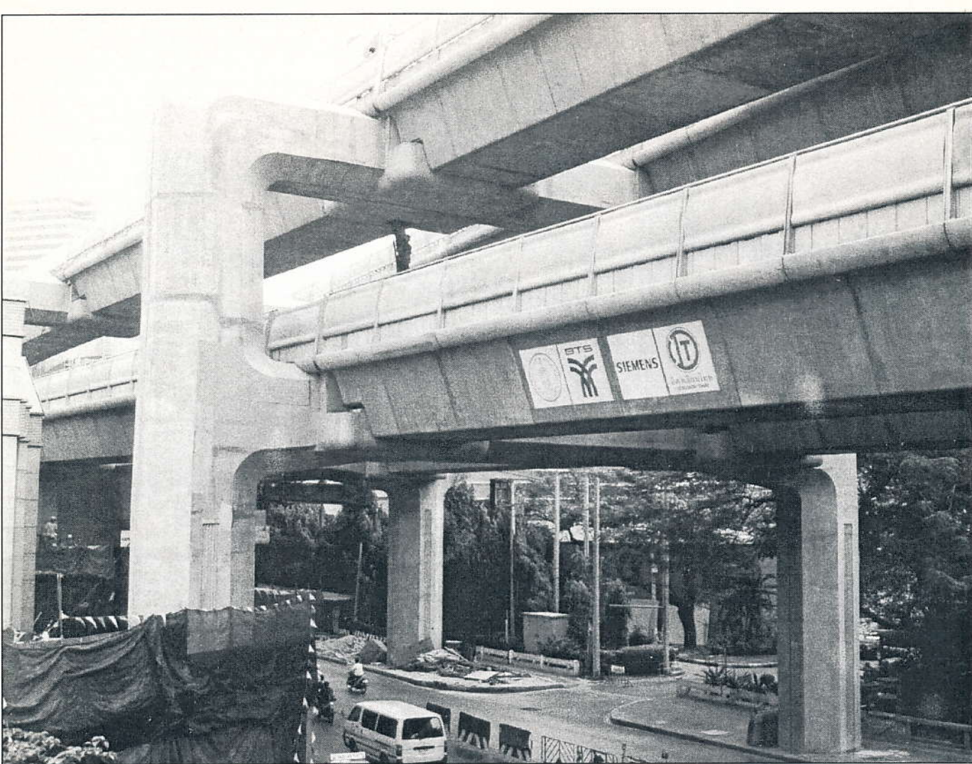
SkyTrainin ratakaukaloita rakenteilla Bangkokissa. Ilmaratoja tulee kulkemaan paikoitellen useassa tasossa. 12.2.1999.
