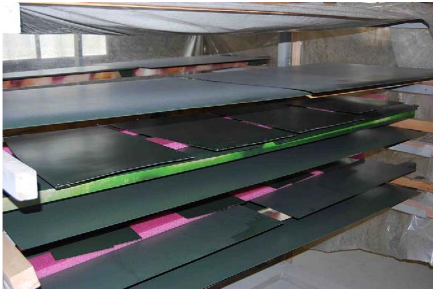
Vaunun pellit valmiiksi maalattuina. Huonokuntoisimmat pellit on jouduttu uusimaan, mutta iso osa pelleistä on vanhoja. Ei kuitenkaan alkuperäisiä, vaan jossain vaiheessa vaihdettuja
