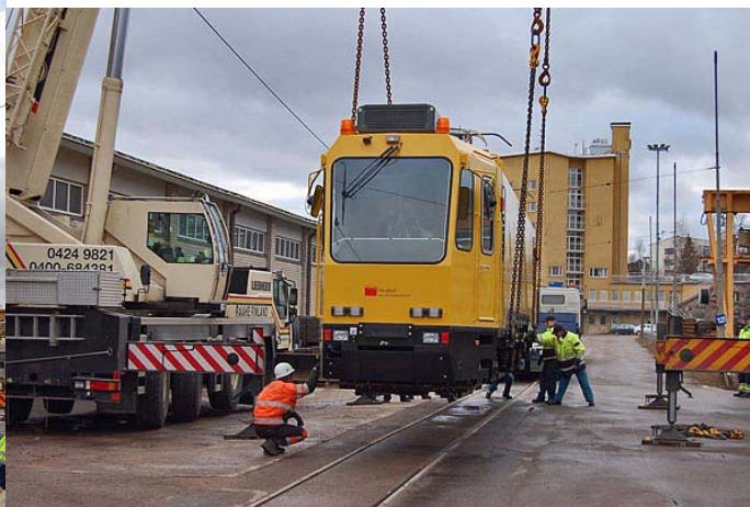
Vaunun nosto ja lasku reiteille / Lifting of the car. Kuvat / Photos © Jorma Rauhala 4.11.2010.
