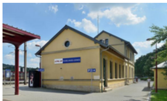
Afbeelding 7: Station Dudelange-Usines (Bron: Cayambe )
