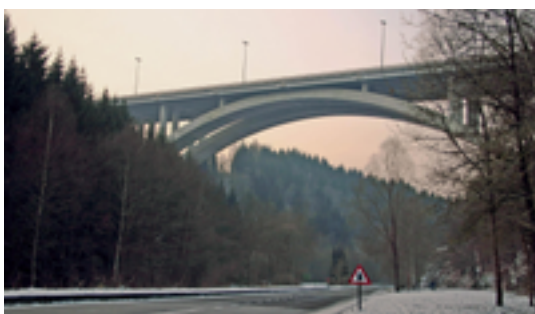
Afbeelding 14: Viaduct E25 van Houffalize (Bron: Wikimedia )
