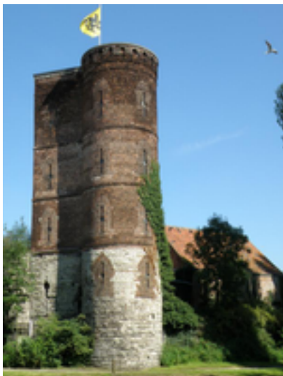
Afbeelding 16: Graventoren Rupelmonde (Bron: Torsade de Pointes )
