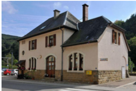
Afbeelding 27: Station Goebelsmühle (Bron: Jwh )
