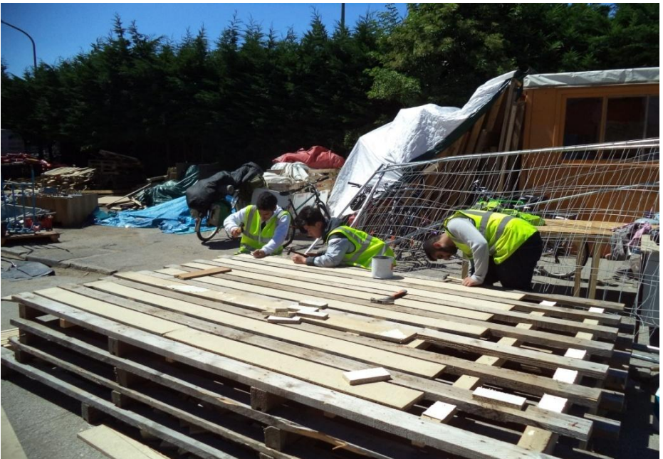
Pallets uit elkaar halen en in kleine stukken hakken en zagen zodat de kachel kan branden
