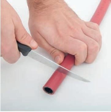
Schlauch rechtwinklig mit scharfem Messer oder Schlauchabschneider (SAS26) abschneiden.
